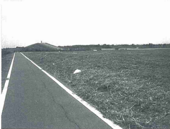
〈写真5〉1600 m地点付近の盛り土
