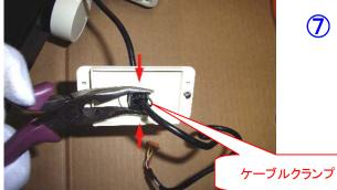
ペンチで "ケーブルクランプ" を挟み "キャルパネル" から外します
