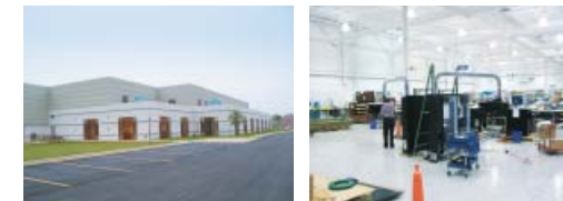
ADTの建物全景 ADTの製品組立スペースの様子
