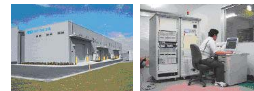
増設した実験棟の全景 実験設備を監視する監視室の様子
