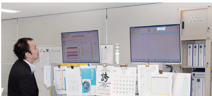
車両状態監視装置の画面を確認
