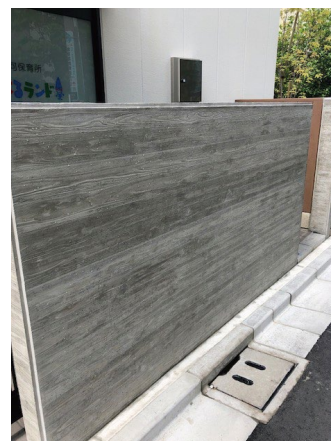
「ライジングコート」の施工例 コンクリート打ち放し壁面を補修し、木目調に仕上げ
